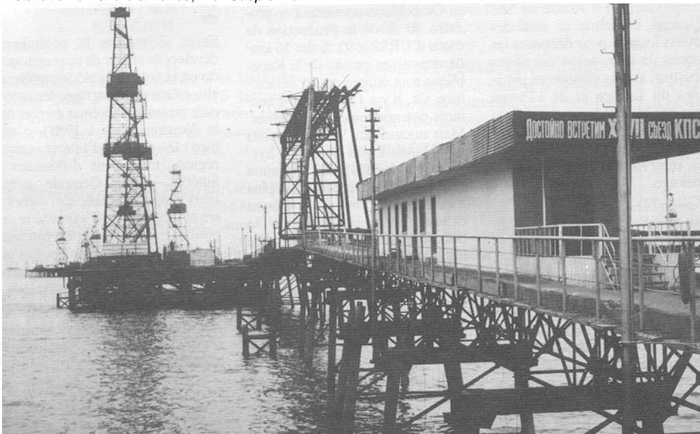
Installation off-shore à Bakou, Mer Caspienne.
