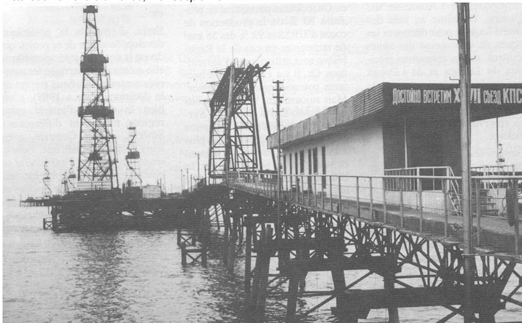
Installation off-shore à Bakou, Mer Caspienne.
